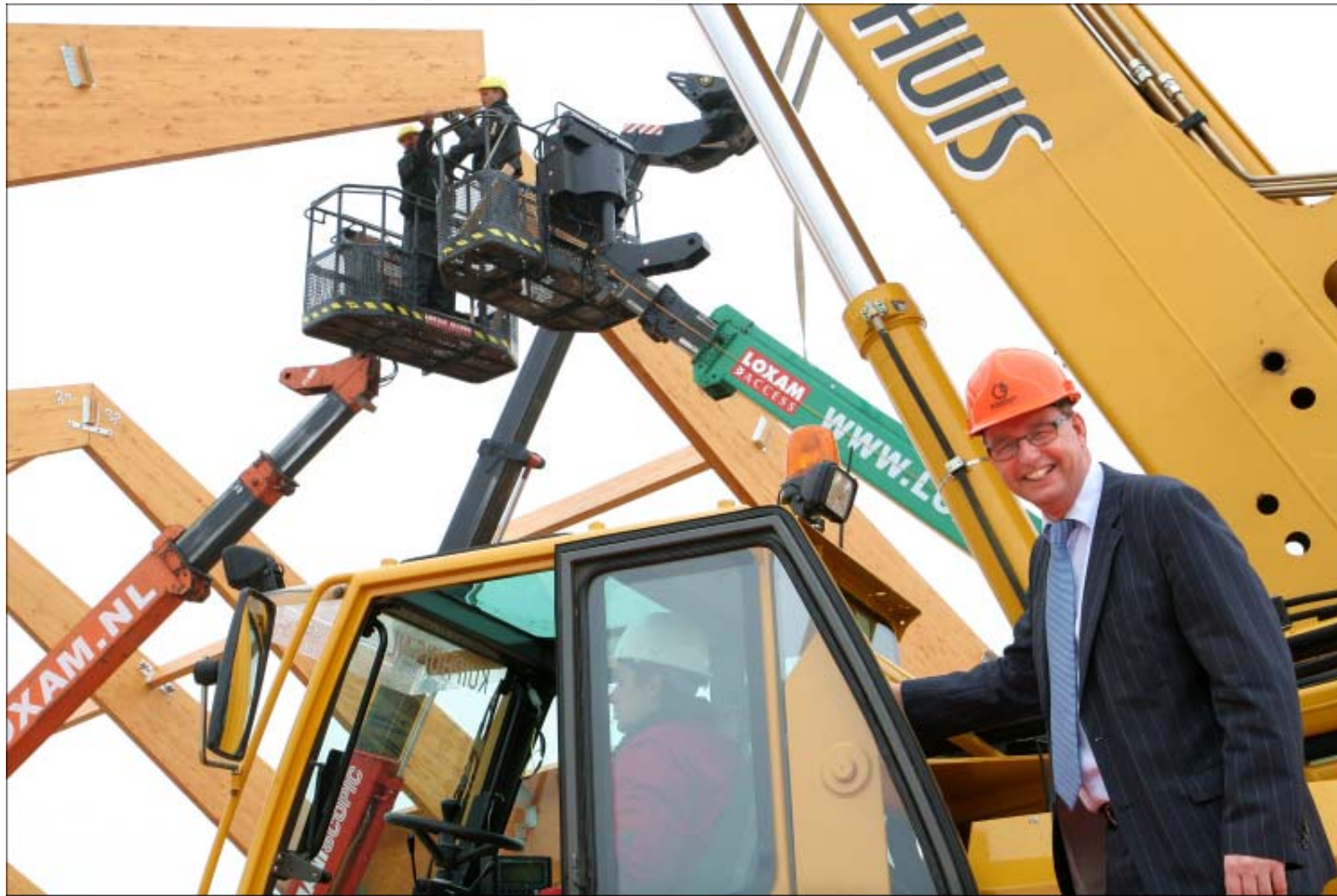
Wethouder Jannes Janssen startte de bouw van de gemeentewerf aan de Haardijk met het plaatsen van een spant.
